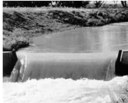
Vertedero de sección trapezoidal
